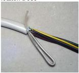
Sobald es kein weiterführendes Kabel mehr gibt, Beidraht mit etwas zu langem Isolierschlauch überziehen und abknicken (oder mit Klemme versehen) für spätere Verwendung. Bei geschirmten Putz- oder Hohl-wanddosen keine ungeschirmten Kabel verwenden!
