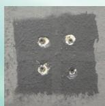
4. Dübel einsetzen und Erdungsplatte festschrauben.
